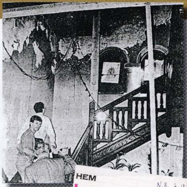
Incendie à la Mairie de Hem relaté et illustré dans Nord Eclair du 7 octobre 1995. Photos Nord Eclair
